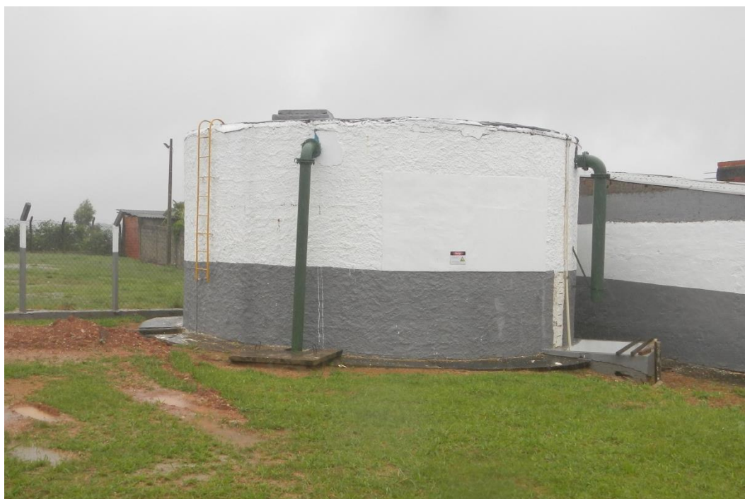
Vista do reservatório pertencente ao CR Flora.
