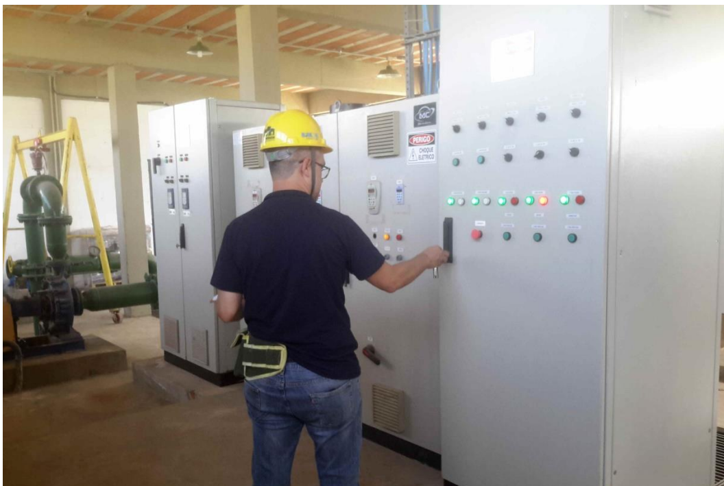
Vista interna das instalações da EEAT – ETA.
