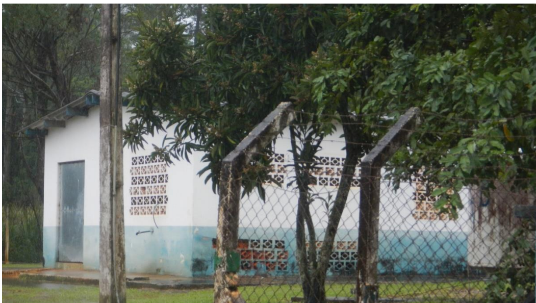
Vista Externa da EEAT Vitória ZB.
