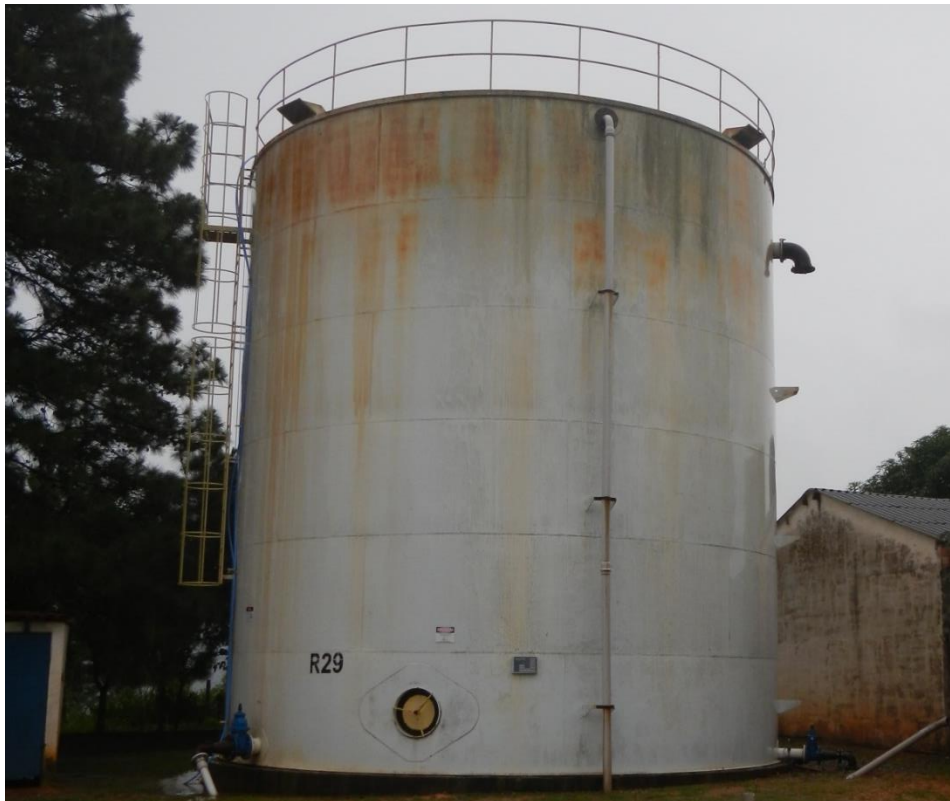
Vista do tanque metálico com 500m 3 de capacidade pertinente ao CR Dona Catarina.
