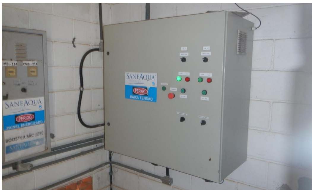
Vista interna das instalações da EEAT – CR São José.
