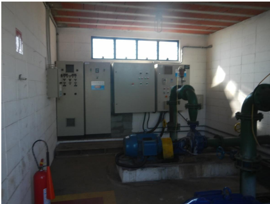
Vista interna das instalações da EEAT – CR Granada-11.
