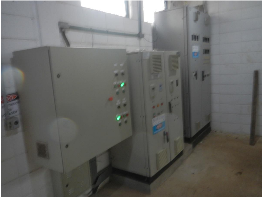
Vista interna das instalações da EEAT Waldez.
