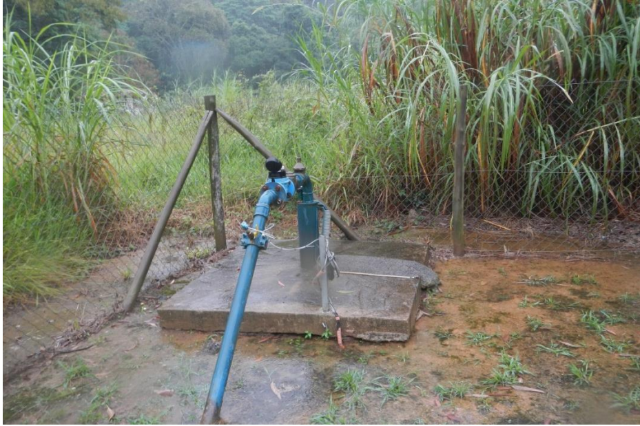
Vista das Instalações do Poço P-18.
