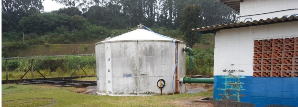
Vista do reservatório instalado na EEAT Ginásio.
