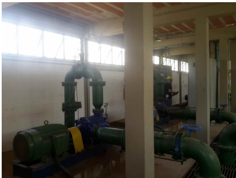
Vista do conjunto 2 de moto-bombas da EEAT – ETA.
