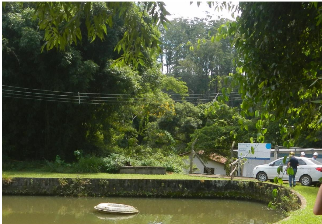
Vista externa parcial das instalações da Captação de Água Bruta Carvalho
