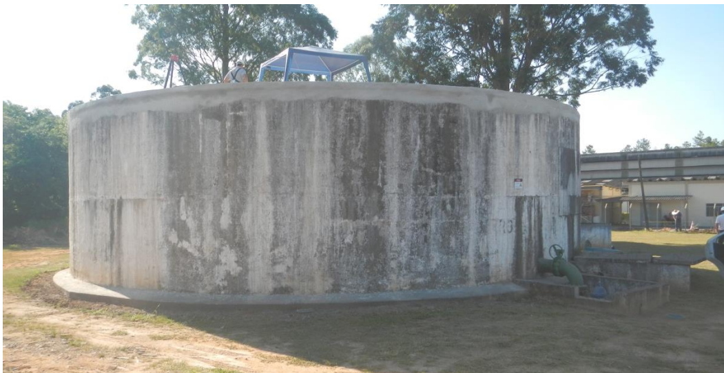
Vista do Reservatório Indústria localizado na área das instalações da EEAT Indústria.
