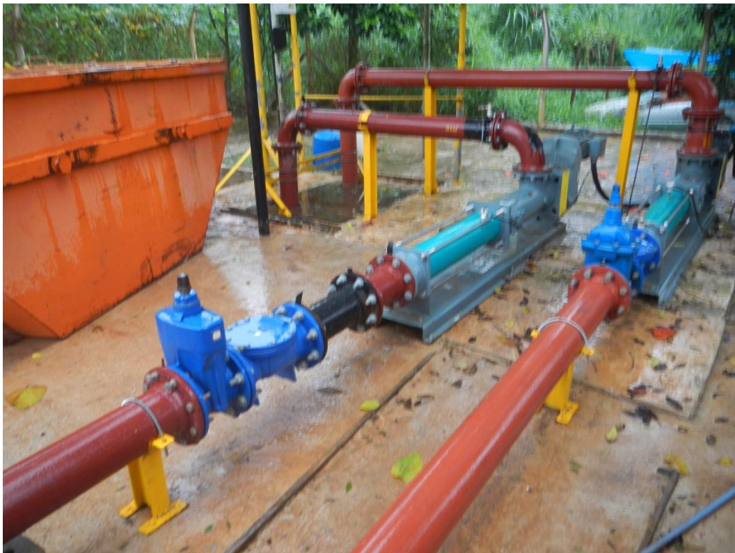
Vista das instalações da EEE Vitória.
