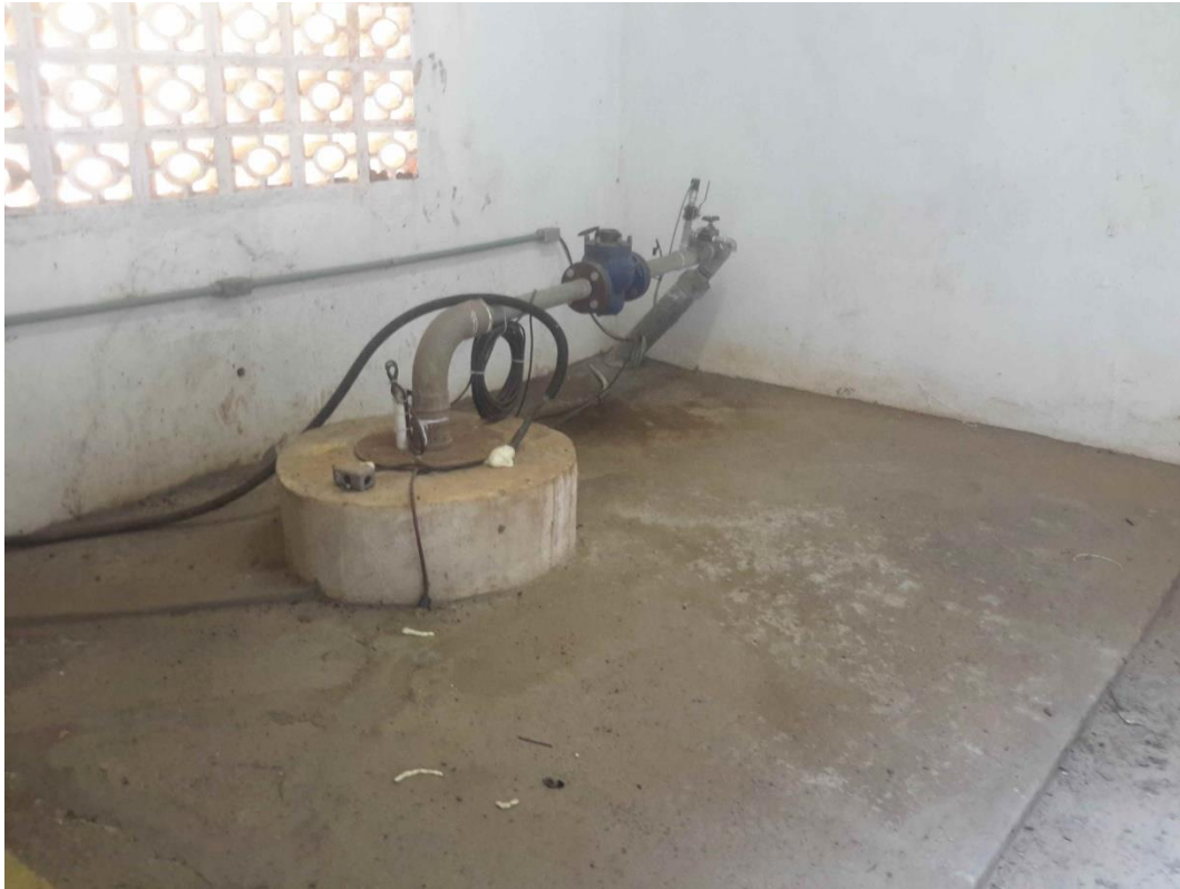
Vista das instalações do Poço P-5.
