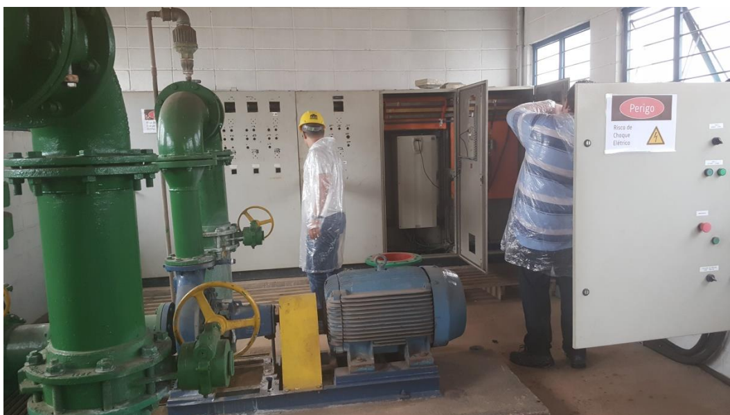
Vista do segundo conjunto moto bomba instalado na EEAT Ginásio e demais instalações.
