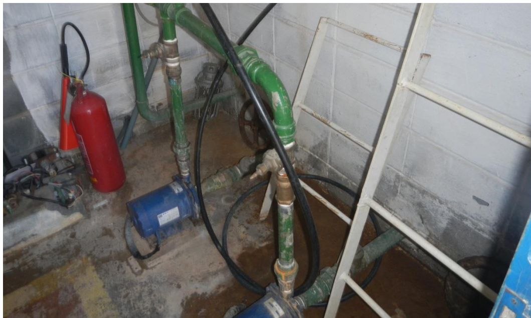
Vista interna das instalações do booster – CR – Recanto.
