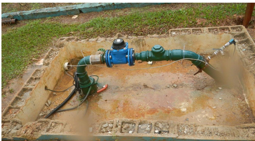
Vista das Instalações do Poço P-17.
