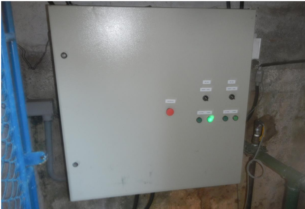
Vista interna das instalações da EEAT – CR Bombeiro.
