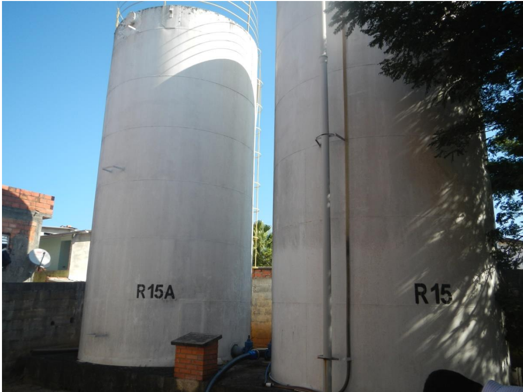
Vista do Reservatório CR Haydée
