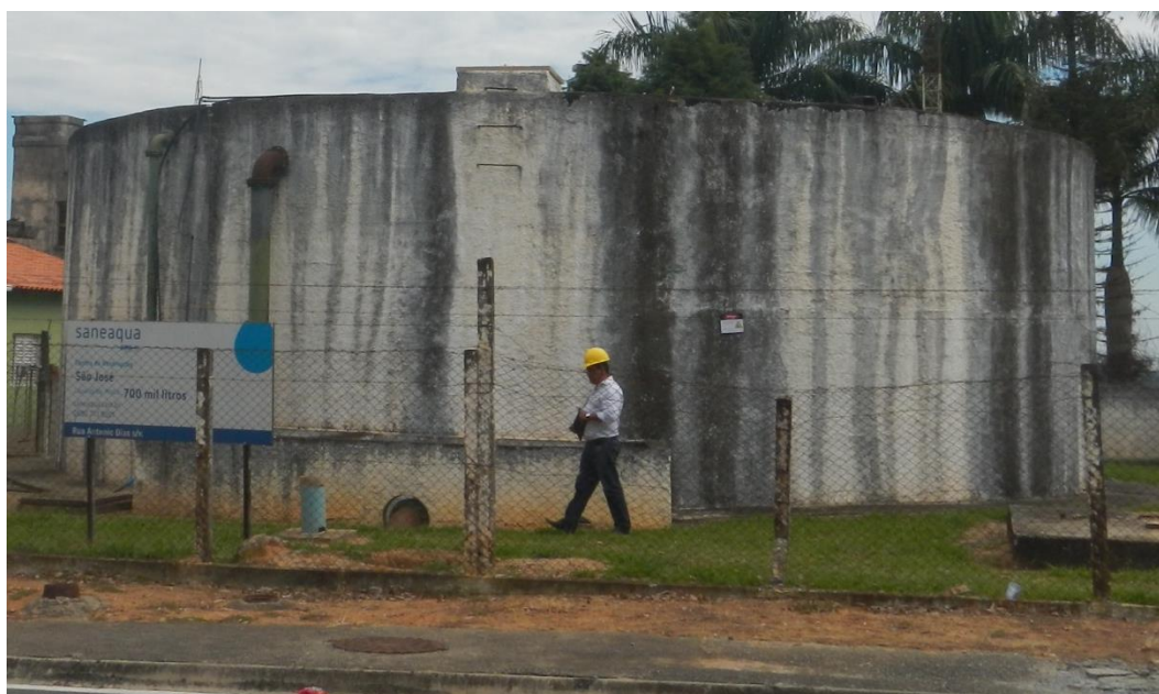
Vista do Reservatório pertinente ao CR São José com capacidade de 700 m 3 .
