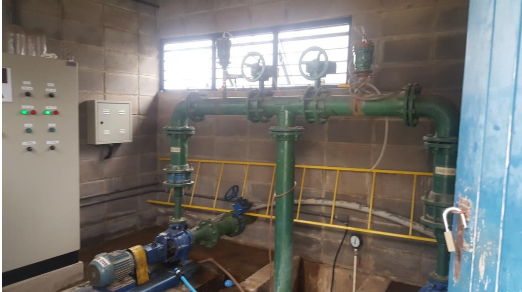
Vista do conjunto de Moto-bombas que compõem a EEAT – CR CECAP.
