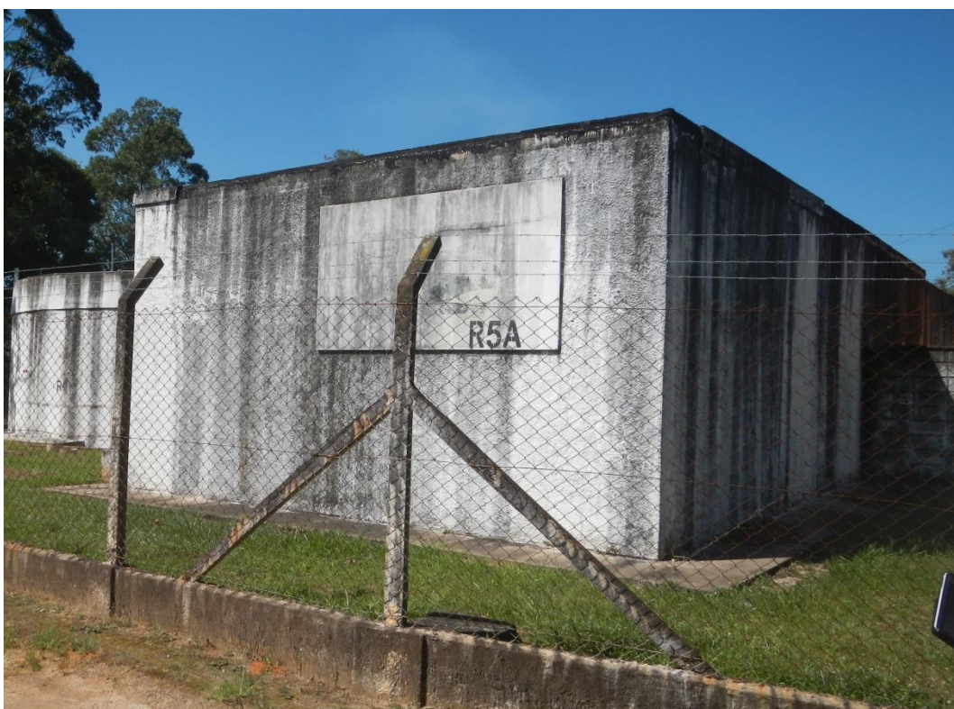
Vista do Reservatório R5A e R4 ao fundo à esquerda pertinentes ao CR Bombeiro.
