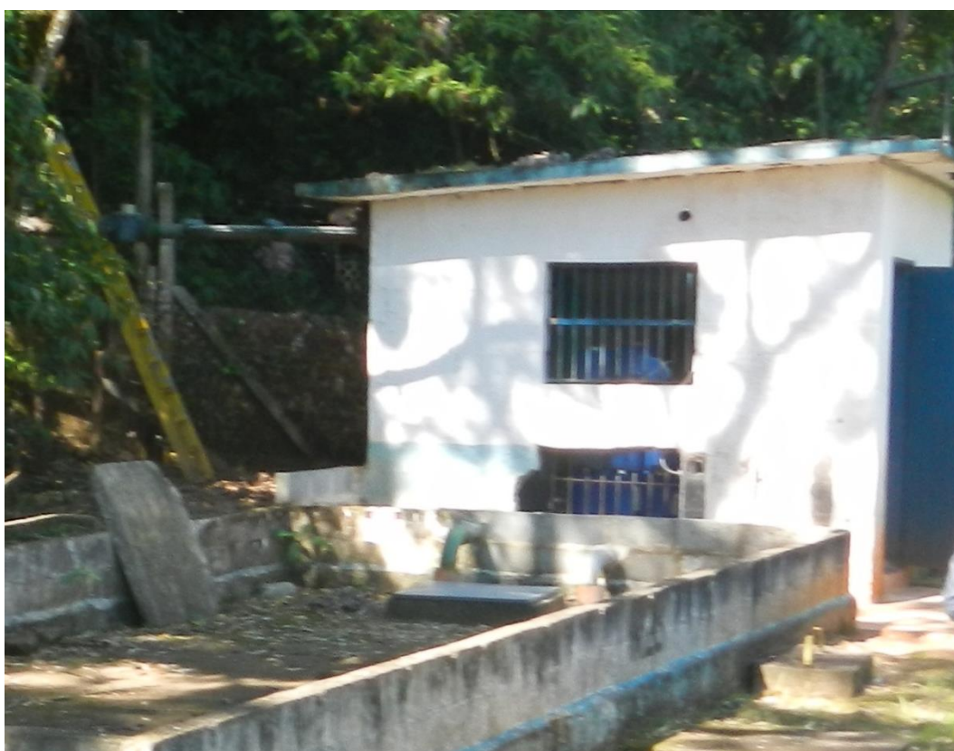
Vista das Instalações do Poço P-19.
