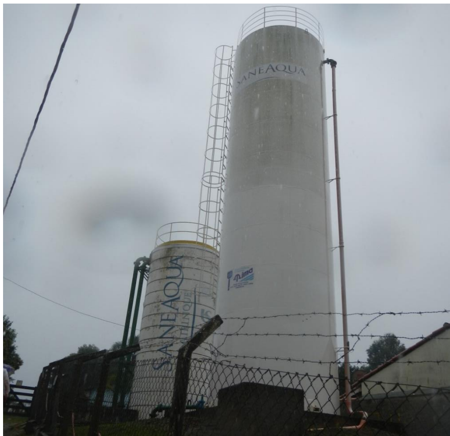
Vista do reservatórios que compõem o CR Vitória ZB2.
