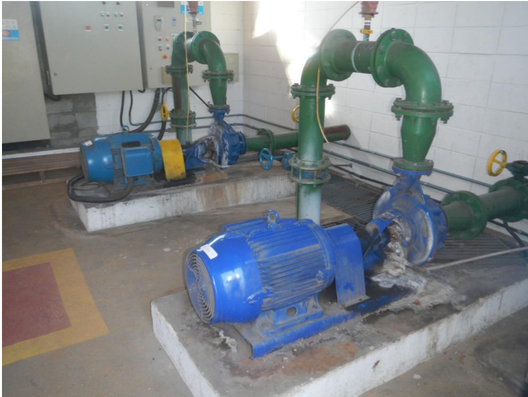
Vista do Conjunto de moto-bombas que compõem a EEAT instalada no CR Granada R-11.
