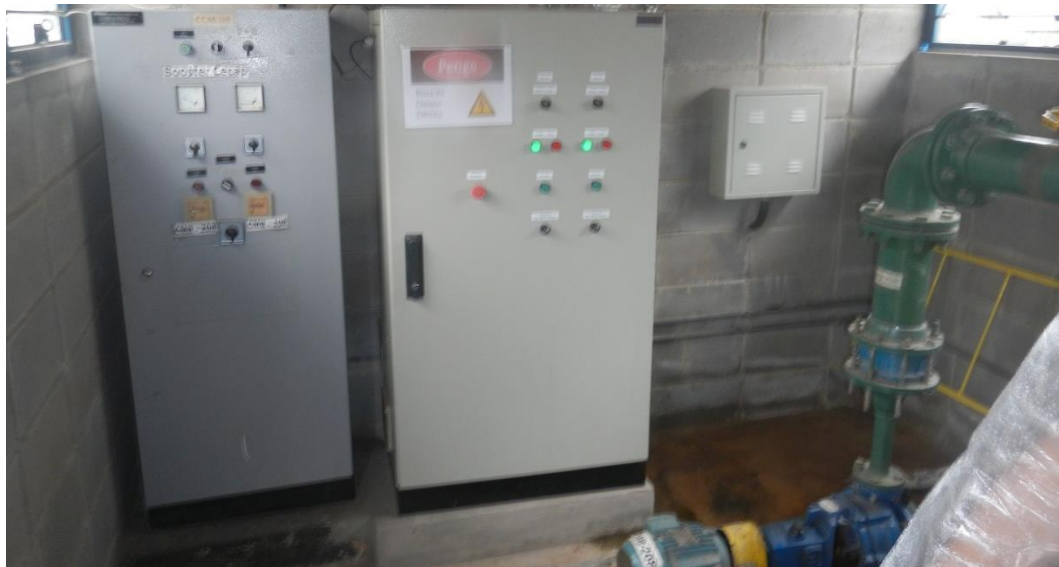
Vista interna das instalações da EEAT – CR-CECAP.
