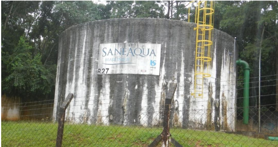
Vista de reservatório instalado na EEAT Waldez.
