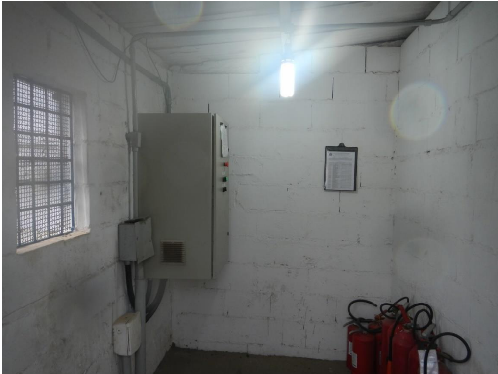
Vista do Quadro de Comando do Poço P-2.
