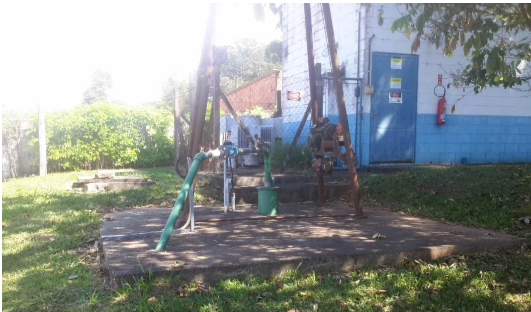
Vista do Poço P-3 implantado dentro das instalações da ETA.
