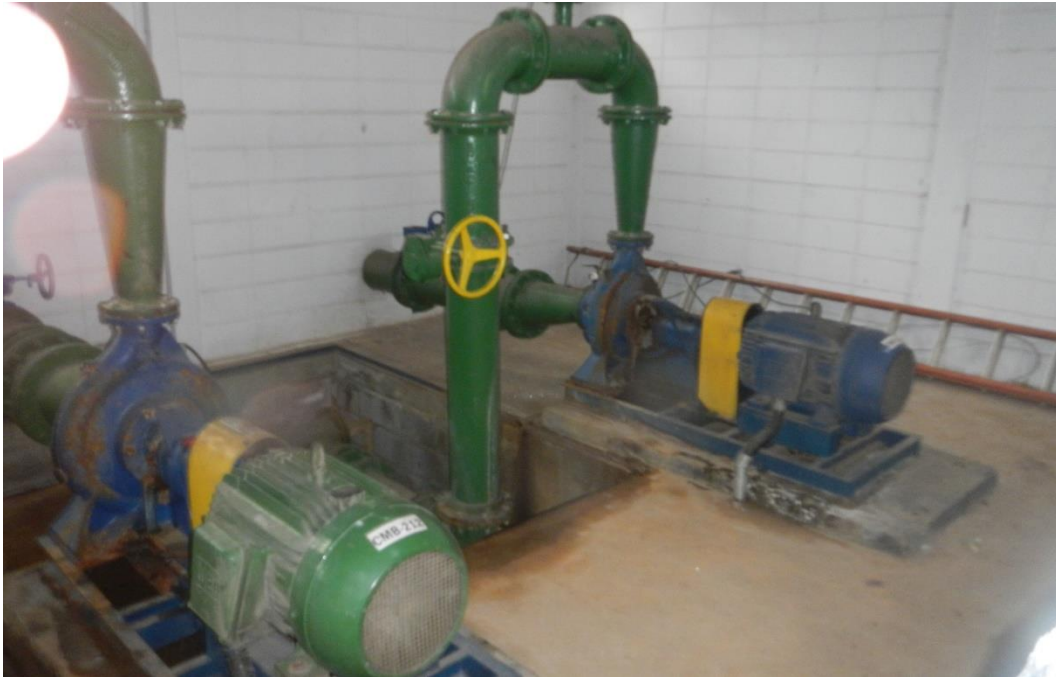
Vista do primeiro conjunto de moto bombas instaladas na EEAT Waldez.
