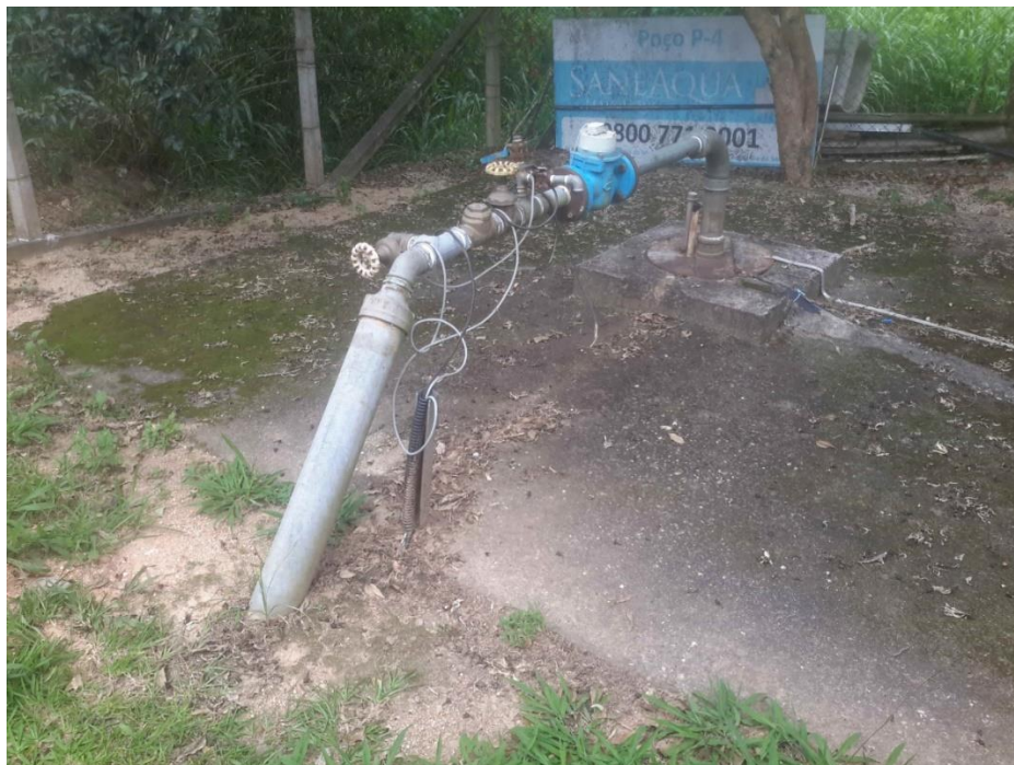
Vista das instalações do Poço P-4.
