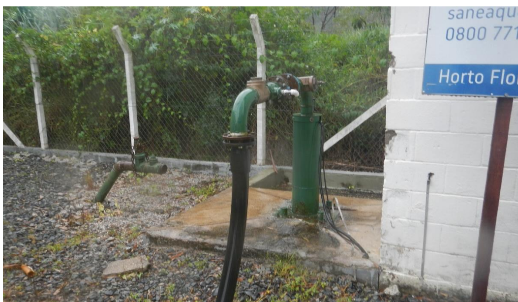
Vista das Instalações do Poço P-14.
