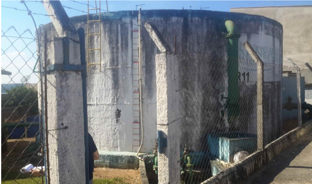
Vista do Reservatório R11 instalado nas dependências da EEAT Granada R-11.
