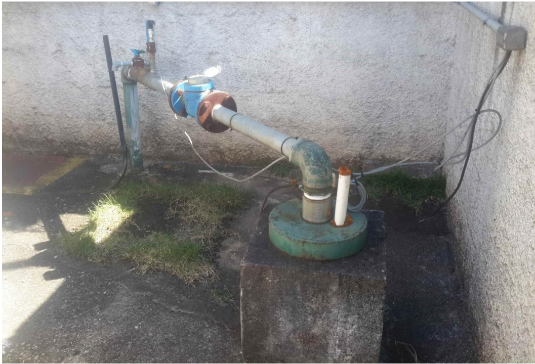
Vista das instalações do Poço P-9.
