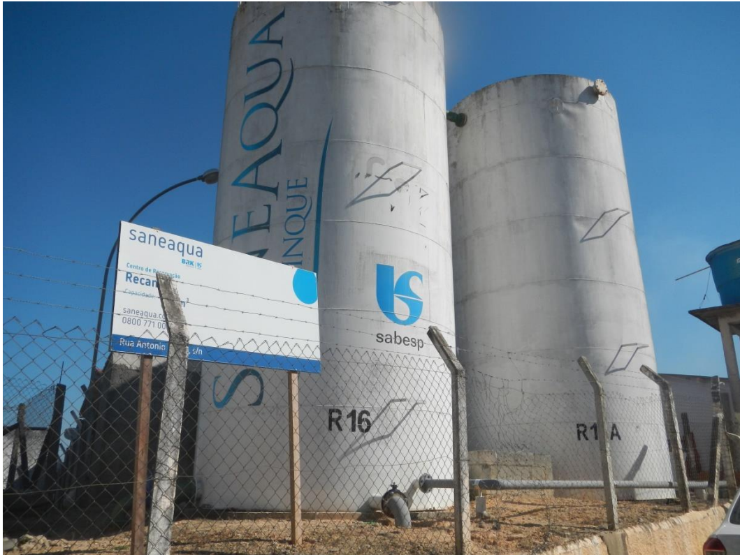
Vista dos reservatórios metálicos do CR Recanto.
