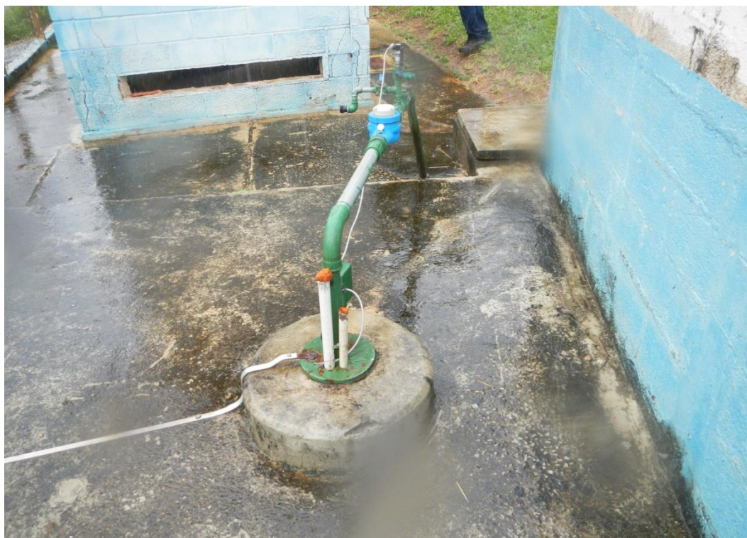
Vista das instalações do Poço P-11.
