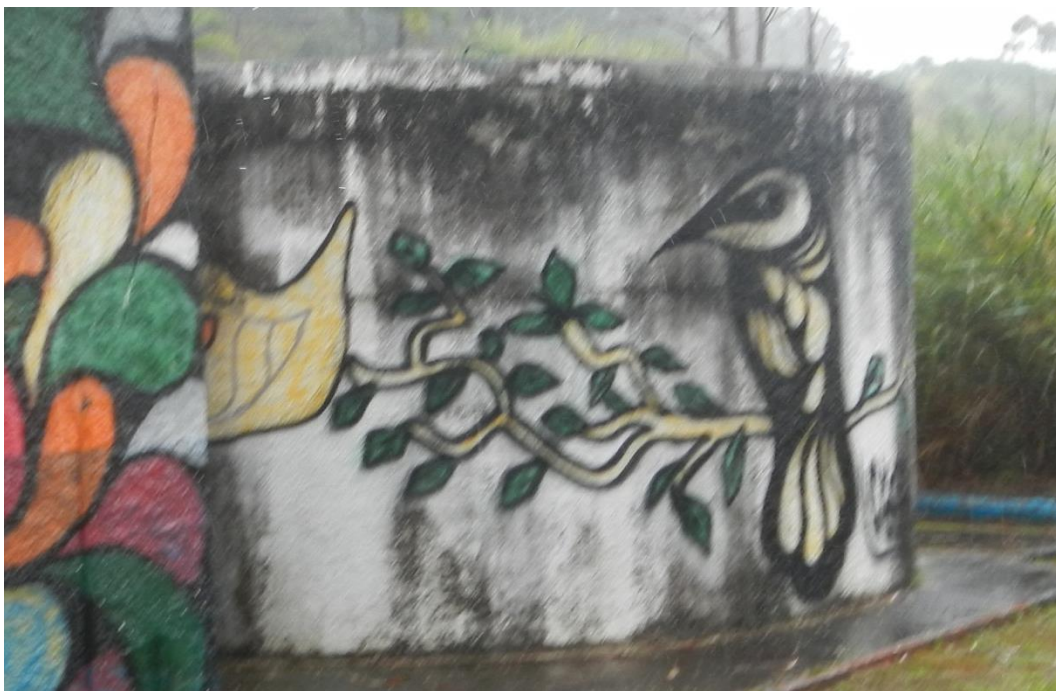
Vista do reservatório instalado junto ao Poço P-10.
