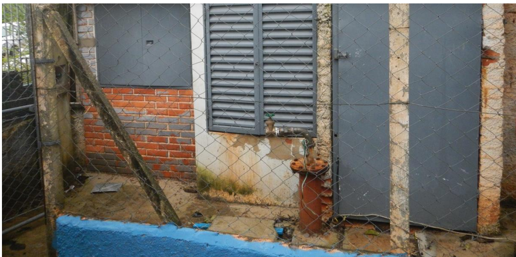
Vista das instalações do Poço P-17b.
