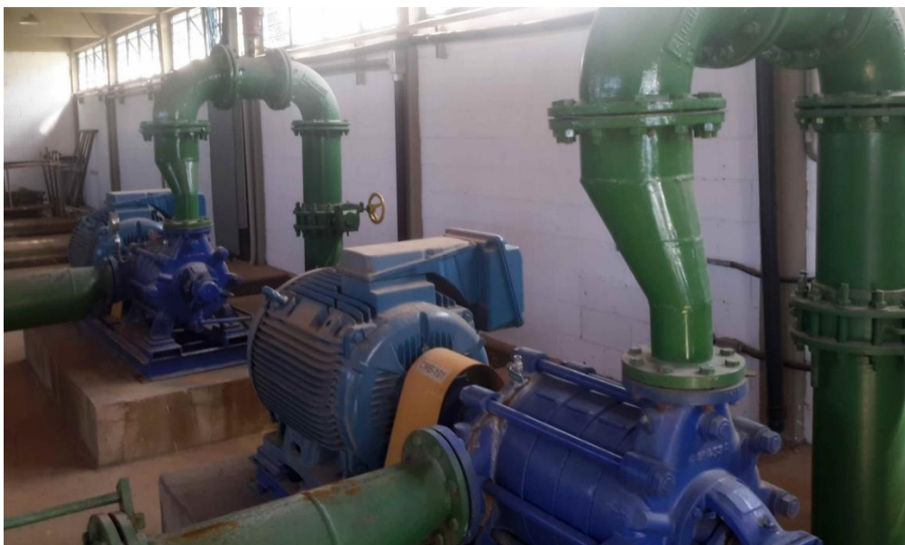
Vista do conjunto 1 de moto-bombas da EEAT – ETA.
